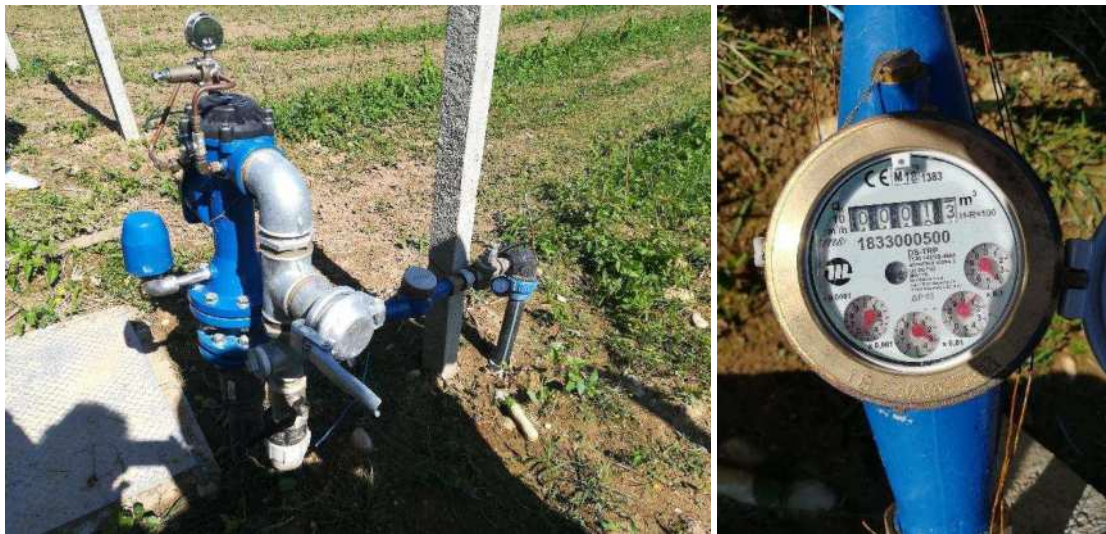
Fig. 5. Bouche d'irrigation avec connexion Camlock (à gauche) et détail d'un compteur volumétrique (à droite).
