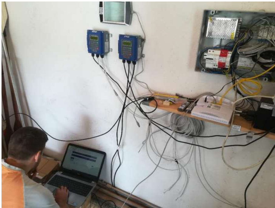
Fig. 15. Installazione del nuovo sistema di trasmissione dati nel mese di settembre 2021.
