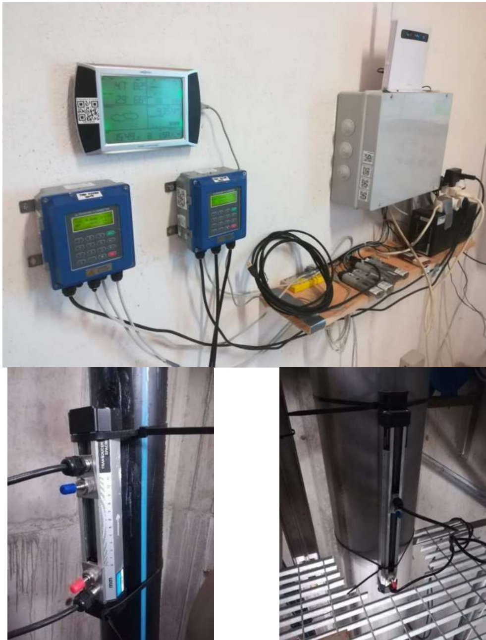
Fig. 11. Débitmètres à ultrasons utilisés pour les mesures sur les canalisations sous pression.
