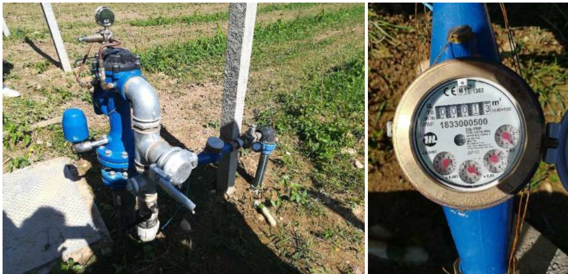
Fig. 5. Bocchetta irrigua con attacco Camlock (a sx) e particolare di un contatore volumetrico (a dx).
